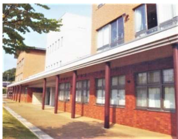
回廊に続くエントランス
